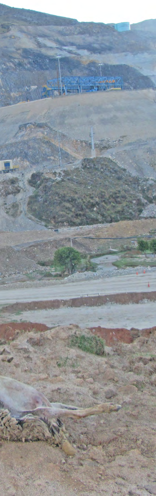
Construcción de la mina Las Bambas en Fuerabamba, Perú. Foto: Henry Vasquez
