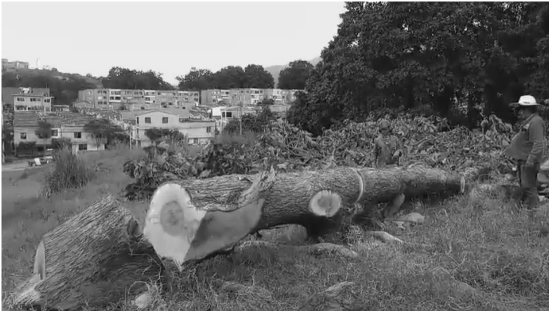
Funcionarios de la constructora Marval talando árboles en el barrio Paseo del Puente 2, Piedecuesta. Foto: Semana.
